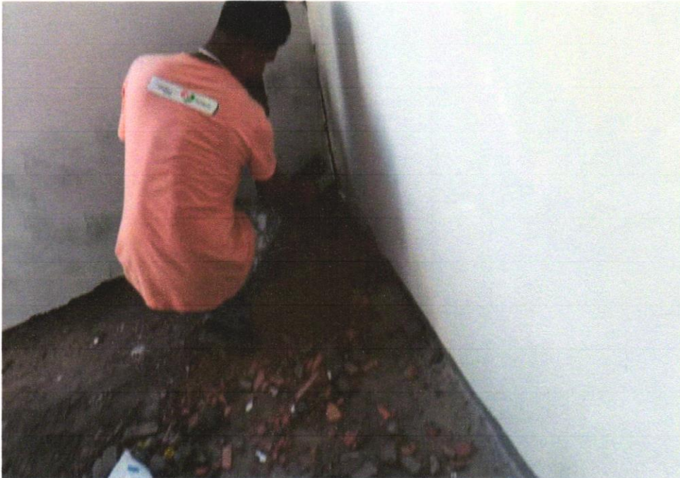
Foto 11 - APLICAÇÃO E LIXAMENTO DE MASSA LÁTEX EM PAREDES, UMA DEMÃO. AF_06/2014
