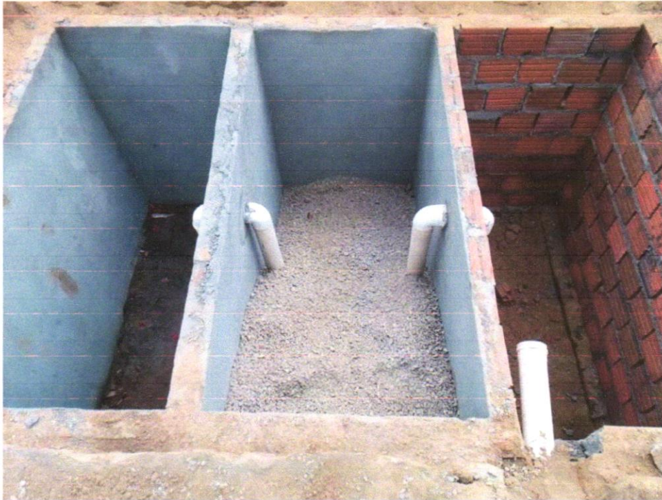
Foto 21 - Fossa séptica pré-moldada, tipo oms, capacidade 20 pessoas (v=1410 litros)
