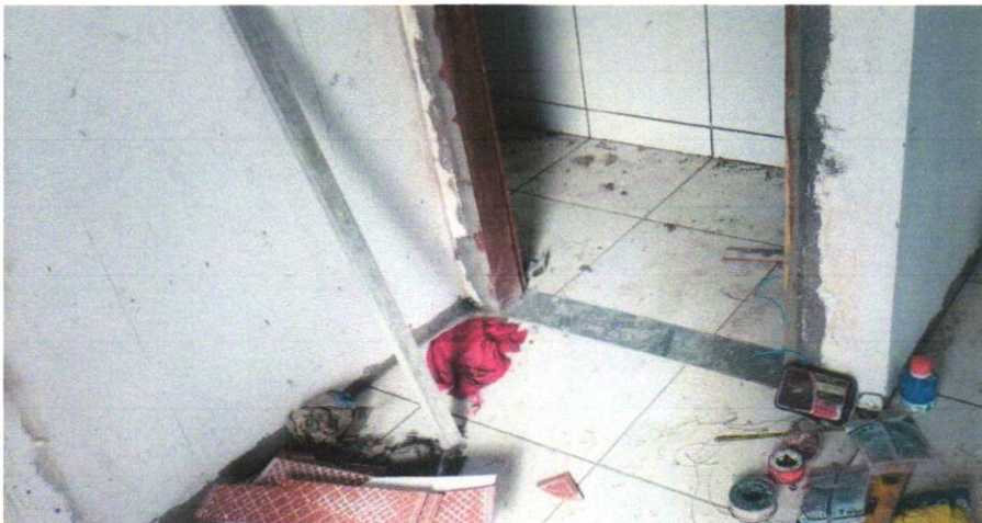
Foto 10 - SOLEIRA EM GRANITO, LARGURA 15 CM, ESPESSURA 2,0 CM. AF_09/2020
