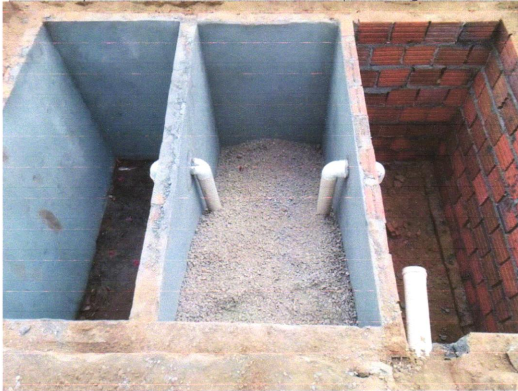
Foto 23 - Sumidouro paredes com blocos cerâmicos 6 furos e dimensões internas de 1,75 x 1,00 x 1,00 m
