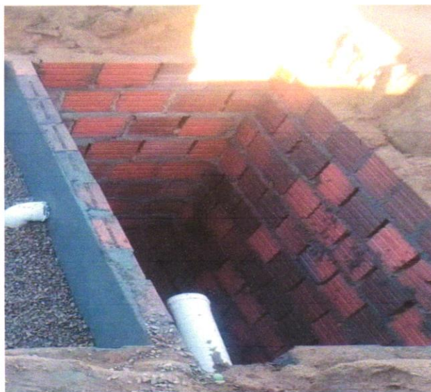
FOTO 01 – ALVENARIA DE VEDAÇÃO DE BLOCOS CERÂMICOS FURADOS NA VERTICAL DE 9X19X39CM (ESPESSURA 9CM) DE PAREDES COM ÁREA LÍQUIDA MAIOR OU IGUAL A 6M 2 COM VÃOS E ARGAMASSA DE ASSENTAMENTO COM PREPARO EM BETONEIRA. AF_06/2014
