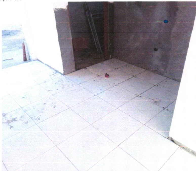
Foto 24 - REVESTIMENTO CERÂMICO PARA PISO COM PLACAS TIPO ESMALTADA EXTRA DE DIMENSÕES 45X45 CM APLICADA EM AMBIENTES DE ÁREA ENTRE 5 M2 E 10 M2. AF_06/2014
