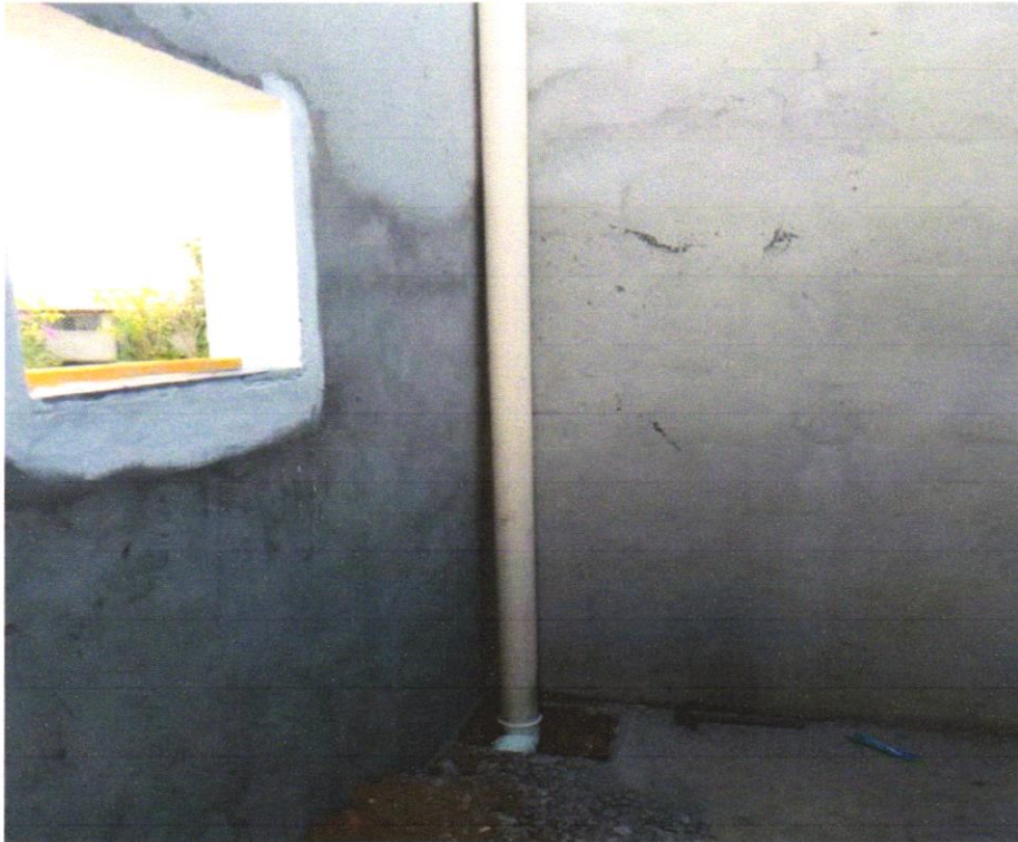
Foto 05 - TUBO PVC, SÉRIE R, ÁGUA PLUVIAL, DN 100 MM, FORNECIDO E INSTALADO EM RAMAL DE ENCAMINHAMENTO. AF_06/2022
