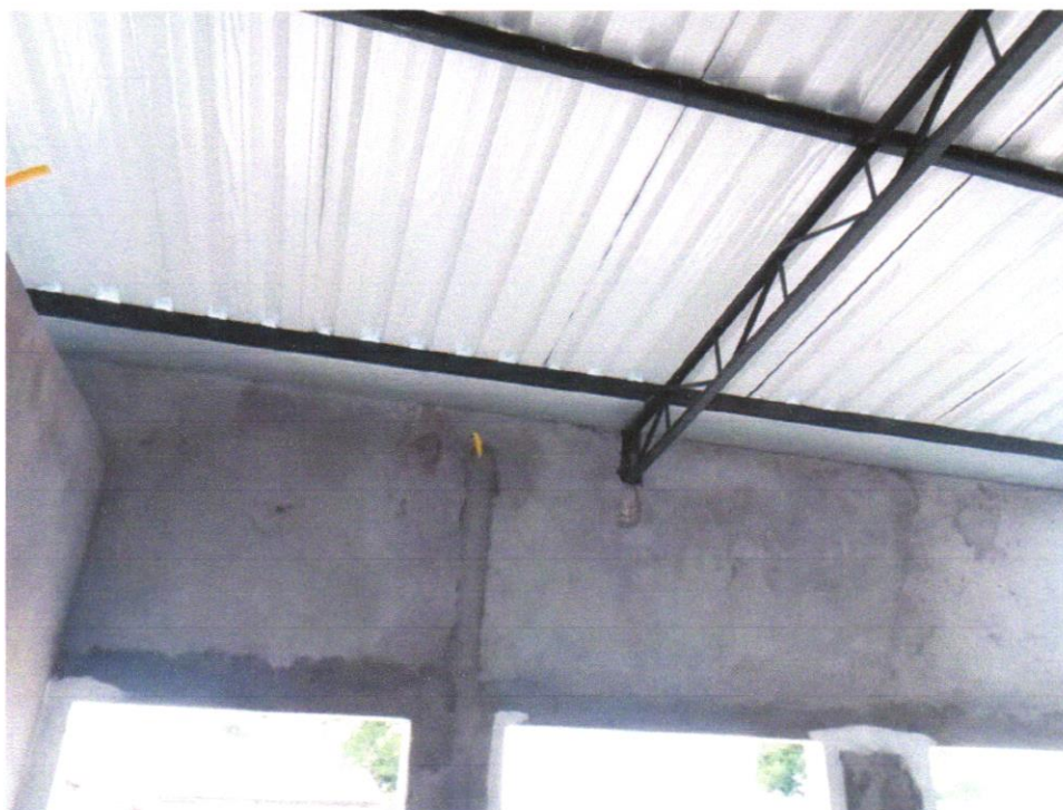
Foto 07 - FABRICAÇÃO E INSTALAÇÃO DE TESOURA INTEIRA EM AÇO, VÃO DE 10 M, PARA TELHA ONDULADA DE FIBROCIMENTO, METÁLICA, PLÁSTICA OU TERMOACÚSTICA, INCLUSO IÇAMENTO. AF_12/2015
