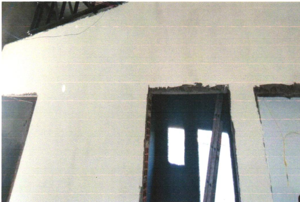
Foto 13 - APLICAÇÃO E LIXAMENTO DE MASSA LÁTEX EM PAREDES, UMA DEMÃO. AF_06/2014
