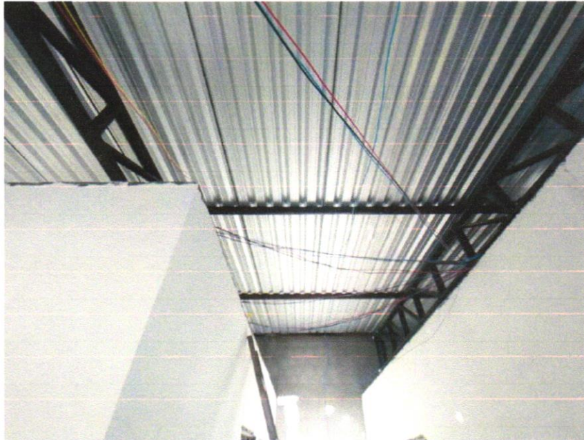
Foto 15 - CABO DE COBRE FLEXÍVEL ISOLADO, 4 MM 2 , ANTI-CHAMA 0,6/1,0 KV, PARA CIRCUITOS TERMINAIS - FORNECIMENTO E INSTALAÇÃO. AF_12/2015
