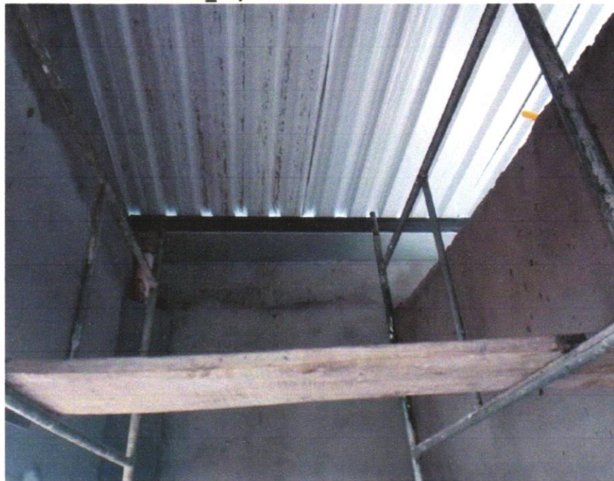
Foto 04 - CALHA EM CHAPA DE AÇO GALVANIZADO NÚMERO 24, DESENVOLVIMENTO DE 100 CM, INCLUSO TRANSPORTE VERTICAL. AF_07/2019
