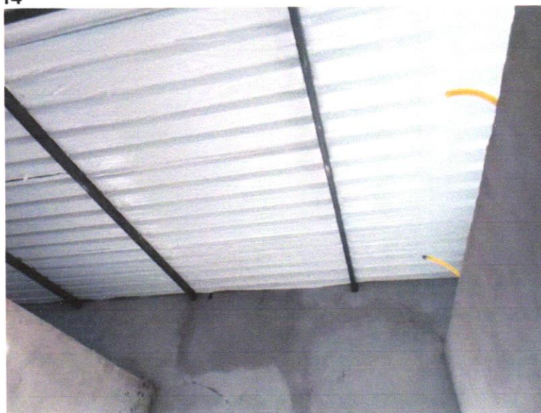
Foto 02 - TELHAMENTO COM TELHA METÁLICA TERMOACÚSTICA E = 30 MM COM ATÉ 2 ÁGUAS, INCLUSO IÇAMENTO. AF_07/2019
