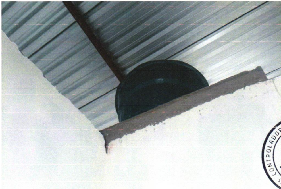
Foto 18 - CAIXA D'ÁGUA EM POLIETILENO, 500 LITROS - FORNECIMENTO E INSTALAÇÃO. AF_06/2021
