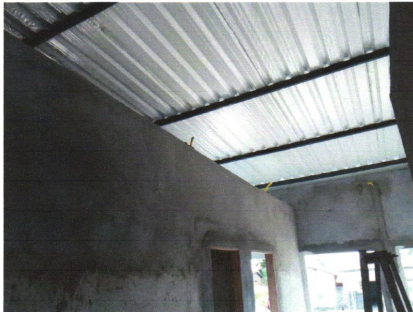
Foto 03 - TRAMA DE AÇO COMPOSTA POR TERÇAS PARA TELHADOS DE ATÉ 2 ÁGUAS PARA TELHA ONDULADA DE FIBROCIMENTO, METÁLICA, PLÁSTICA OU TERMOACÚSTICA, INCLUSO TRANSPORTE VERTICAL. AF_07/2019
